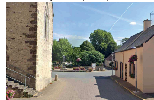
9 A gauche le plot et à droite le mât d'éclairage force le piéton à marcher sur la chaussée.
