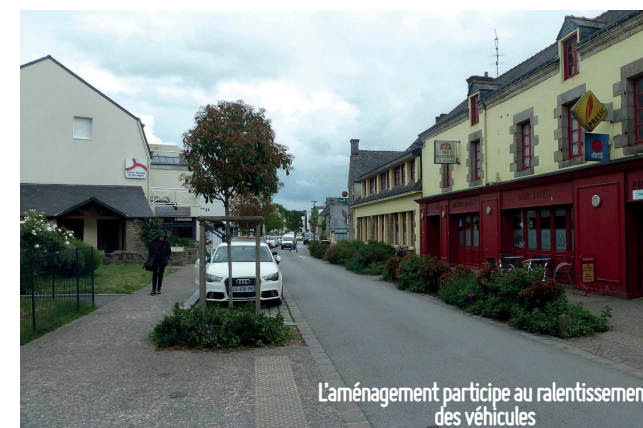
Voie véhicule traversant une place
